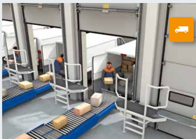
Przeładunek samochodów dostawczych odbywa się na poziomie posadzki hali. W tym celu brama jest otwierana całkowicie z cokółem.
