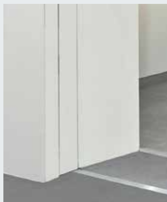
Kłapa do niszy przy otwartej bramie
