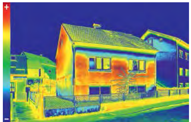
Zdjęcie termograficzne budynku mieszkalnego
