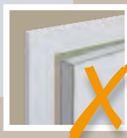
Zwykłe skrzydło drzwiowe z widoczną spoiną
