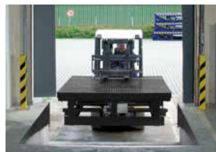
Osadzanie nowej ramy przeładunkowej
