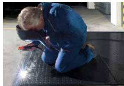
Spawanie do kątowników krawędziowych – gotowe!
