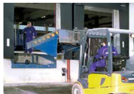
Demontaż starej ramy przeładunkowej, ewentualne dopasowanie gniazda (np. z zastosowaniem płyty montażowej lub konsoli)
